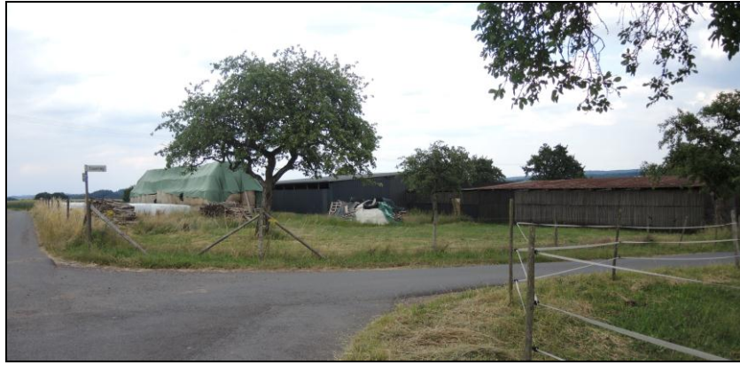
Abb. 7: Blick vom Standort Abzw. „Essering“ in Richtung Südosten auf die bestehenden landwirtschaftlichen Nebengebäude (Foto: KBH Architektur, Juni 2014)
