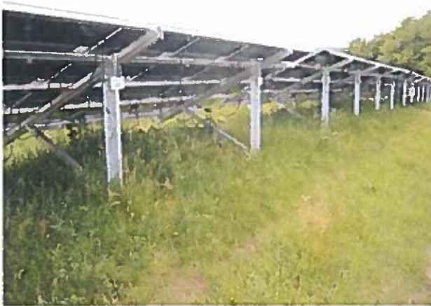
BSP: Unterkonstruktion auf gerammten Stahlpfosten / Stahlkonstruktion
